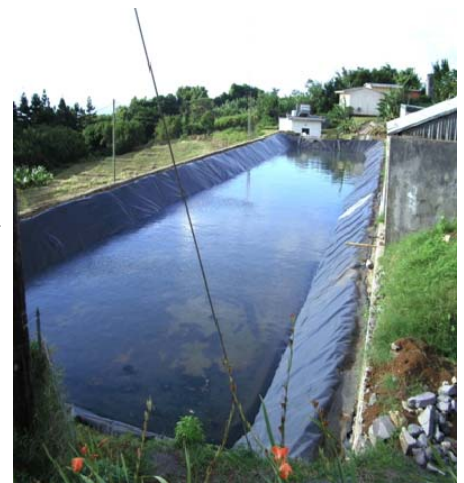
Structure pour le captage d'eau de pluie à Citronnelle
