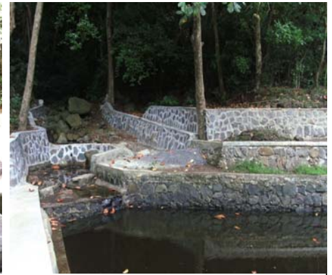
A Fond Accacia on a enlevé la terre du réservoir et entrepris des travaux de consolidation.
